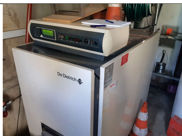
Chaudière à mazout existante
