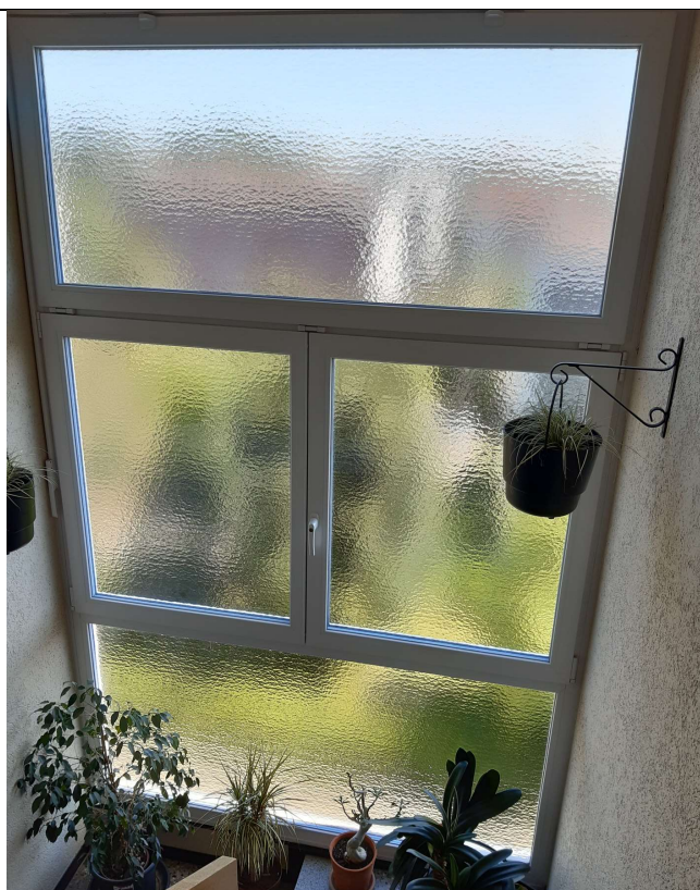
Fenêtre cages escaliers
