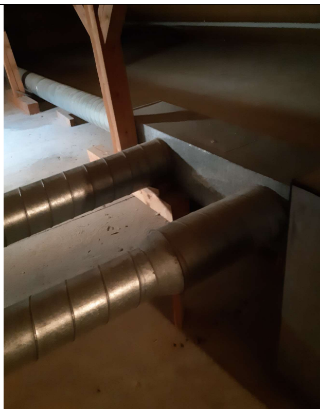
Piquages colonnes vers appartements
