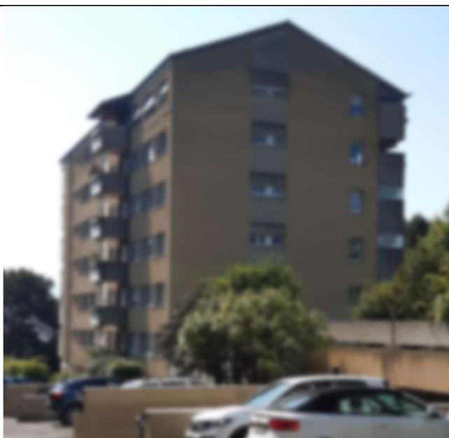
Façade Nord-Ouest de l'immeuble
