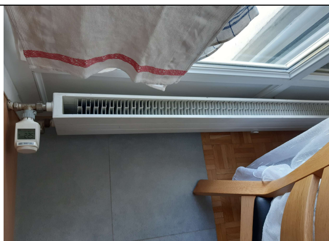
Radiateur muni de vanne thermostatique
