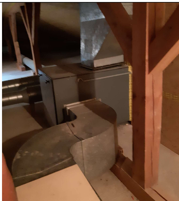
Système de ventilation simple flux
